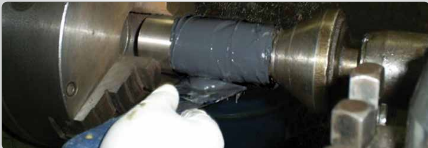
RECUPERAÇÃO DE EIXO COM O PLASTEEL MASSA 4:1
