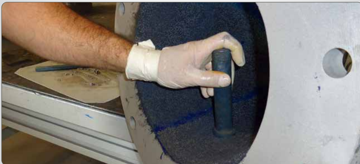
PROTEÇÃO DE BOMBA COM PLASTEEL DIAMANTADO.
